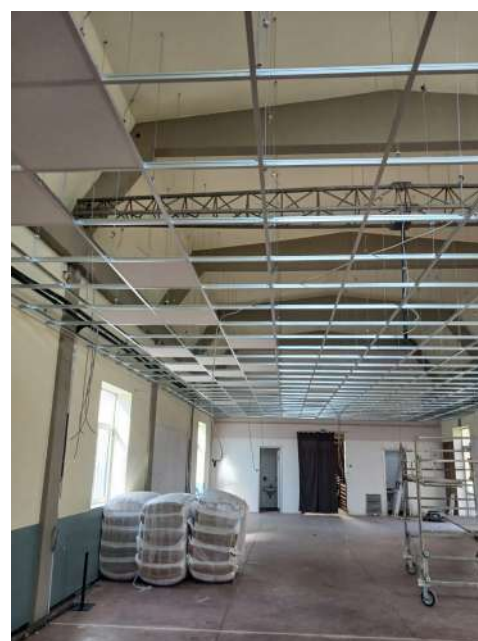
Inizio dei lavori
